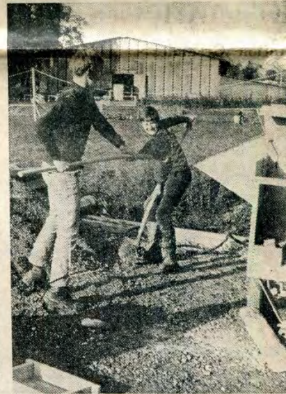
Mit Schwung wird hier die Betonmischmaschine bedient. Keiner zu klein ein Helfer zu sein.
